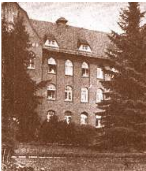
Wrzesień - fragment budynku głównego
