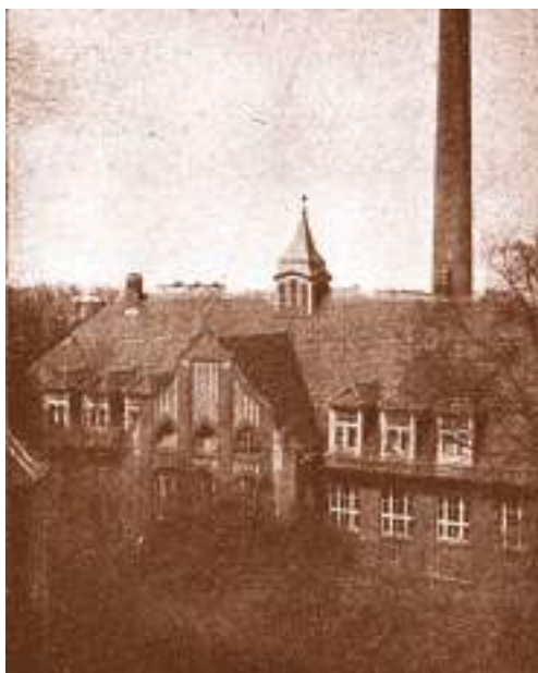
Czerwiec - budynek pralni i maszynowni
