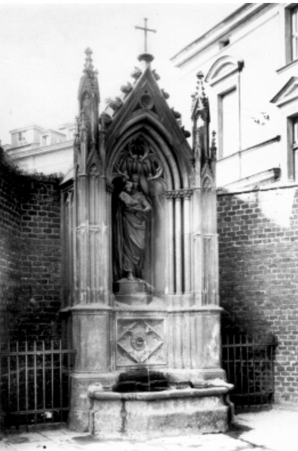
Studzienka przy ul. Długiej, stan sprzed 1939 r.
