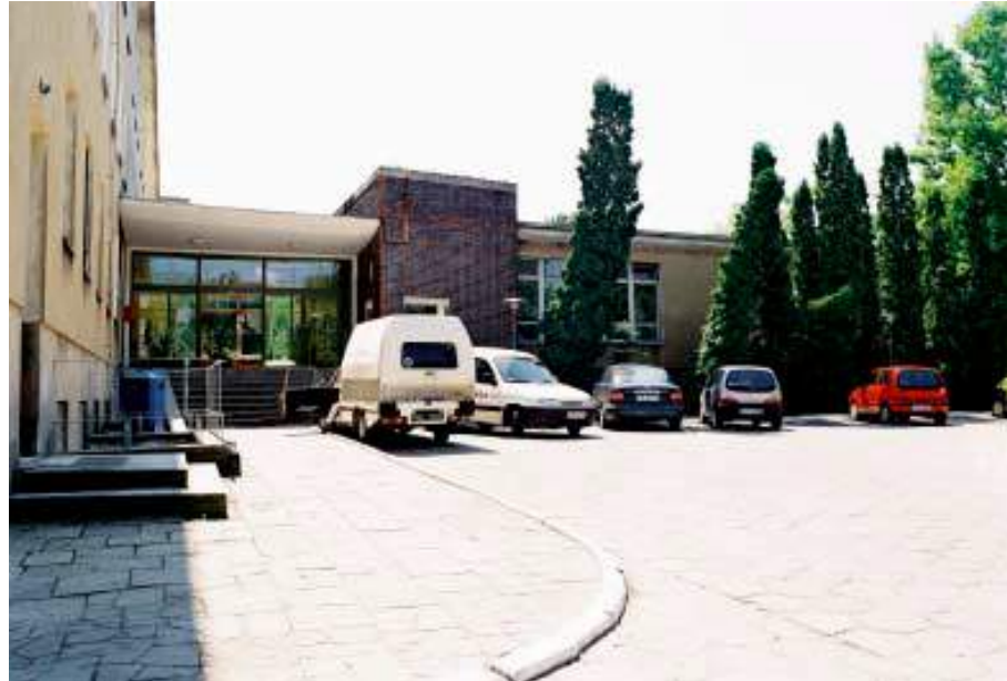
Budynek Szpitala przy ul. Szamarzewskiego
