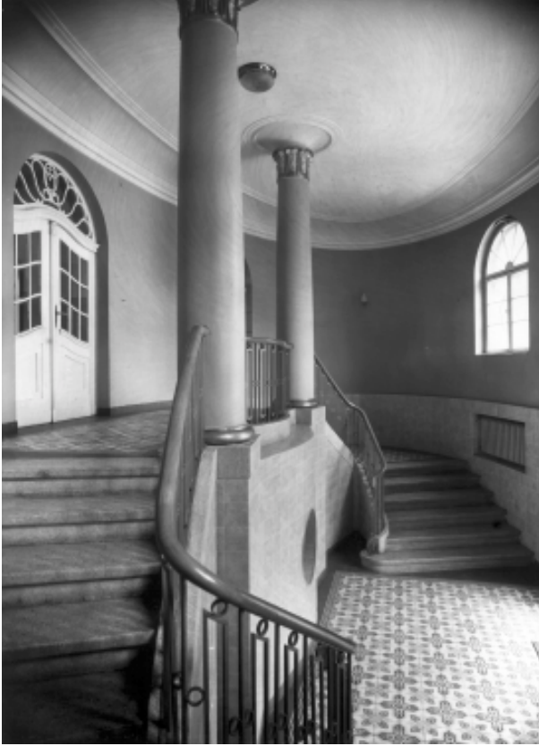
Westybul od strony fasady północnej, wejście główne
