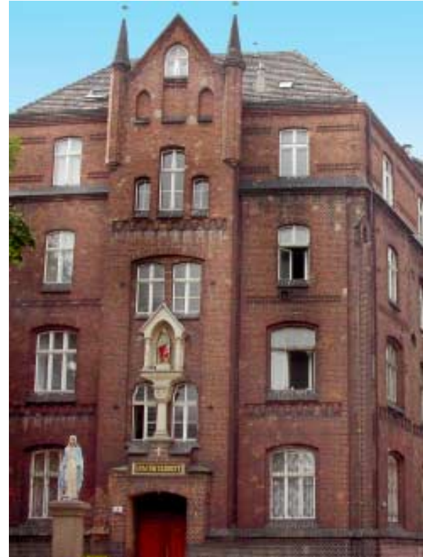
Budynek Szpitala przy ul. Łąkowej
