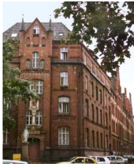
Budynek Szpitala przy ul. Łąkowej 1/2
