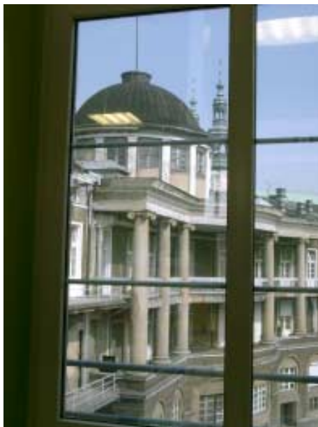
Widok z Kliniki Kardiologii na fasadę południową budynku Szpitala przy ul. Długiej
