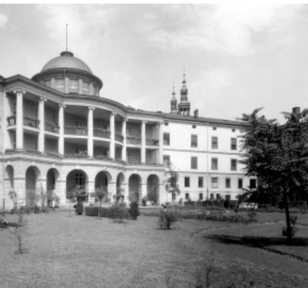
Elewacja południowa Szpitala
