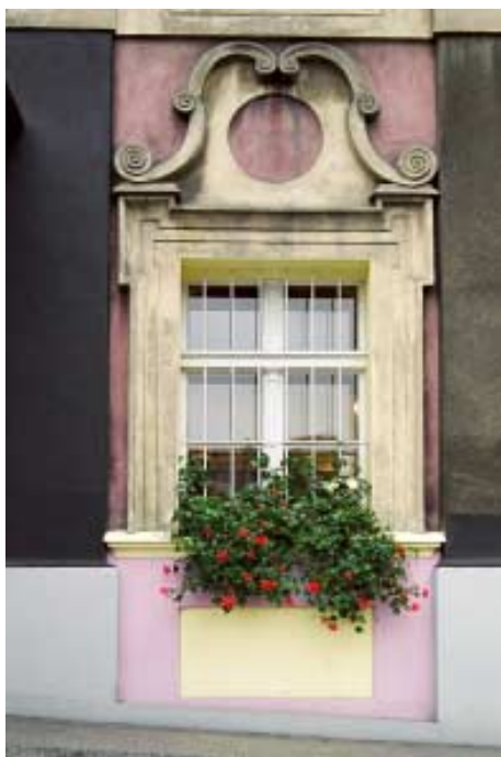
Elewacja od strony ul. Długiej
