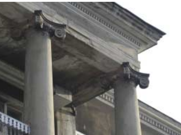
Fragment jońskiego portyku kolumnowego od strony elewacji południowej
